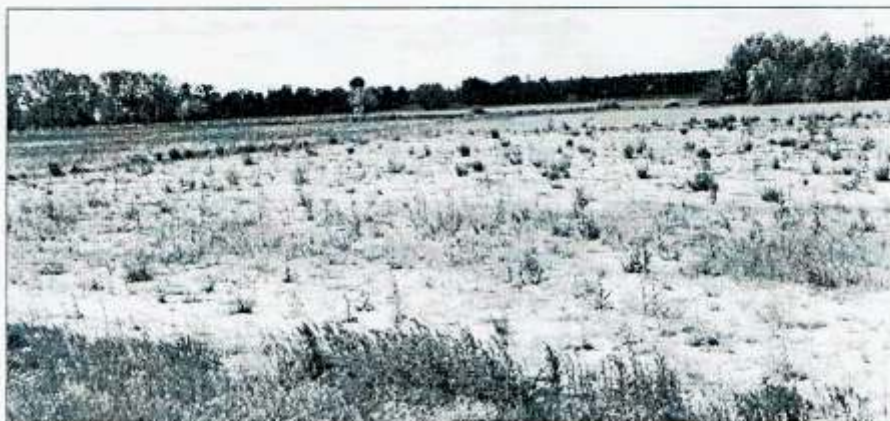
1. Powierzchnia popiołów zabezpieczona 10-centymetrową warstwą piasku
