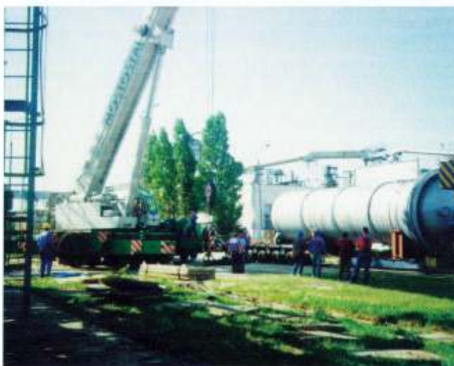
W ramach modernizacji instalacji hydroodsiewacza oleju napędowego dokonano wymiany reaktora
