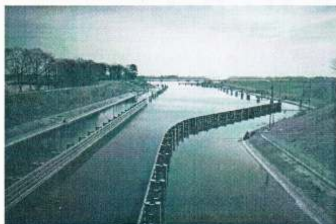
Węście do Śluzy Południowej od Przekopu Wisły
