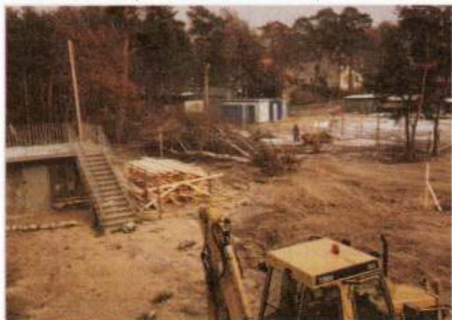
Pierwsze prace ziemne - luty 2001 r.
