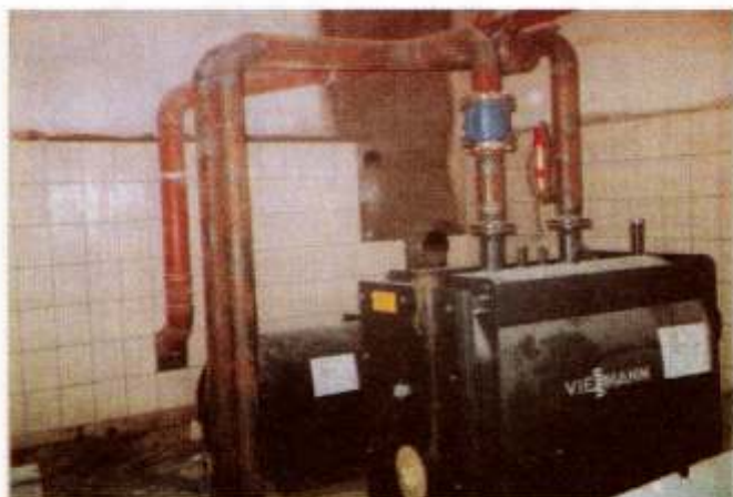
Modernizacja kotłowni - lipiec 2001 r.
