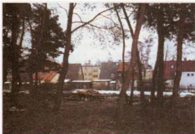
Wycinka drzew przed budową
