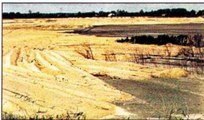
Składowisko w trakcie zabezpieczania go przed pyleniem.
